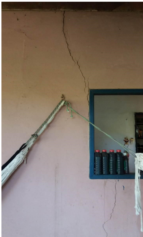
Figura 28: Rachadura surgida em uma casa do Gondó, após o início das detonações. Novembro de 2016.
