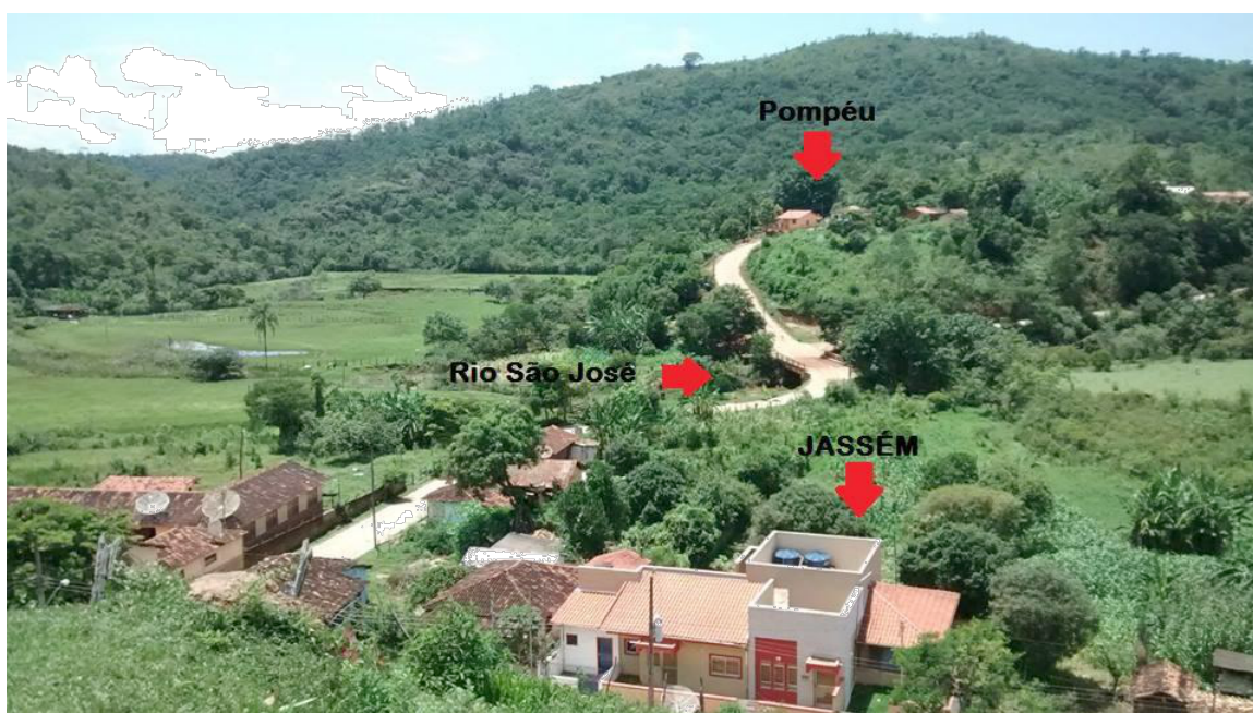
Figura 45: Vista do alto da Igreja – Jassém e Pompéu
